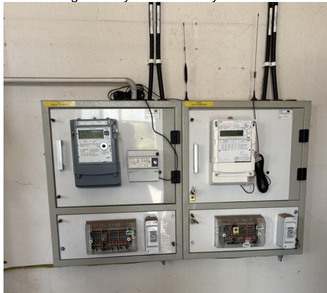
Układ pomiaru energii w budynku technicznym z TAURON i wewnętrzny
